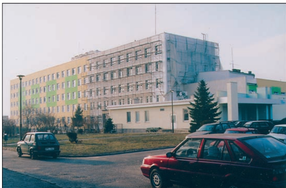
Remont Szpitala - grudzień 2002
