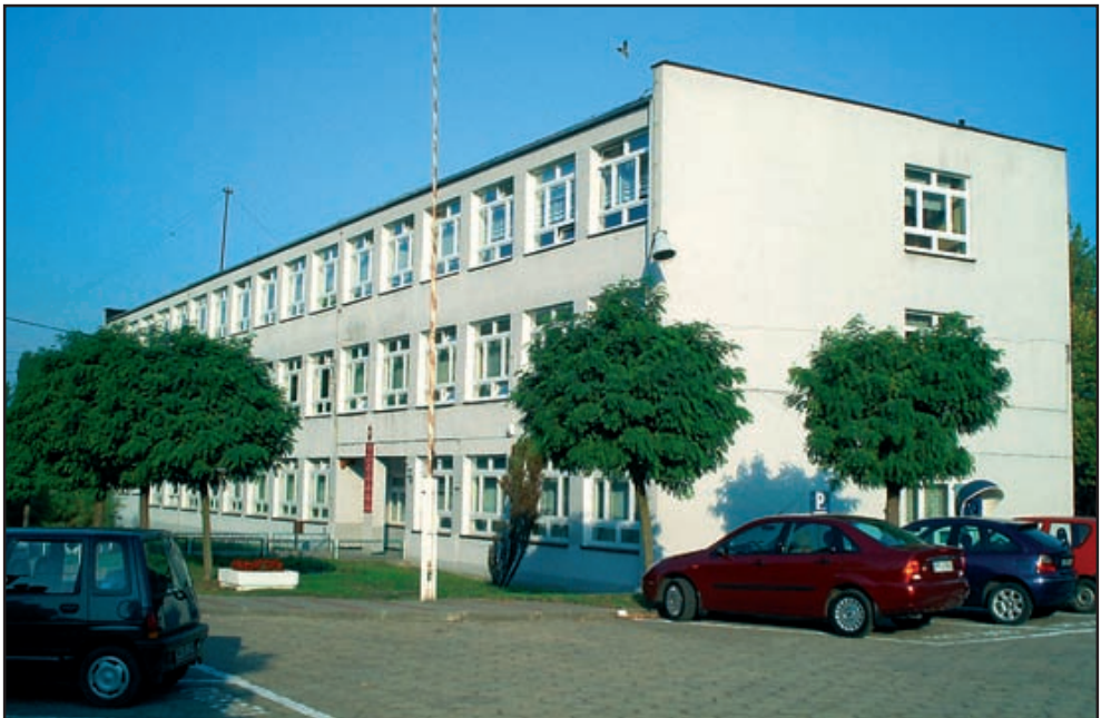
Budynek Zespołu Szkół Rolnicze Centrum Kształcenia Ustawicznego w Marszewie.
