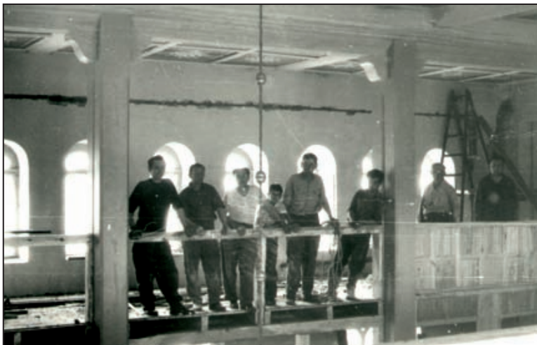
Rok 1967. Prace remontowe na balkonach kościoła.
