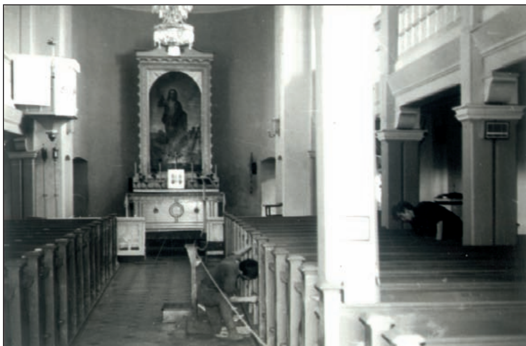
Rok 1969. Wnętrze kościoła. W prezbiterium obraz Najświętszego Zbawiciela oraz nieistniejące już ambona i filar w nawie środkowej. Trwa renowacja ław zakupionych rok wcześniej.
