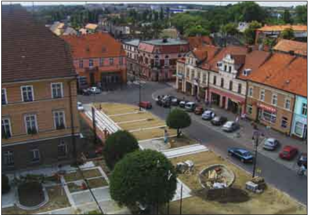
Przebudowa płyty Rynku. Prace wykonuje Przedsiębiorstwo Produkcyjno -Usługowo-Handlowe Gembiak & Mikstacki z Krotoszyna.
