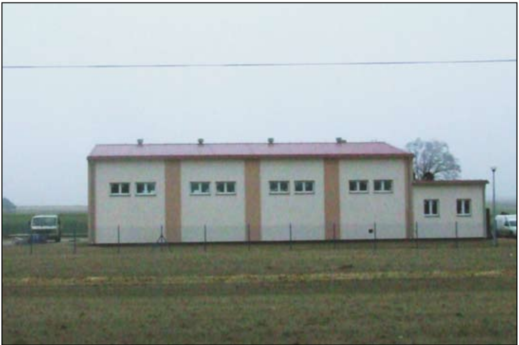
Budynek Stacji Uzdatniania Wody w Lenartowicach.
