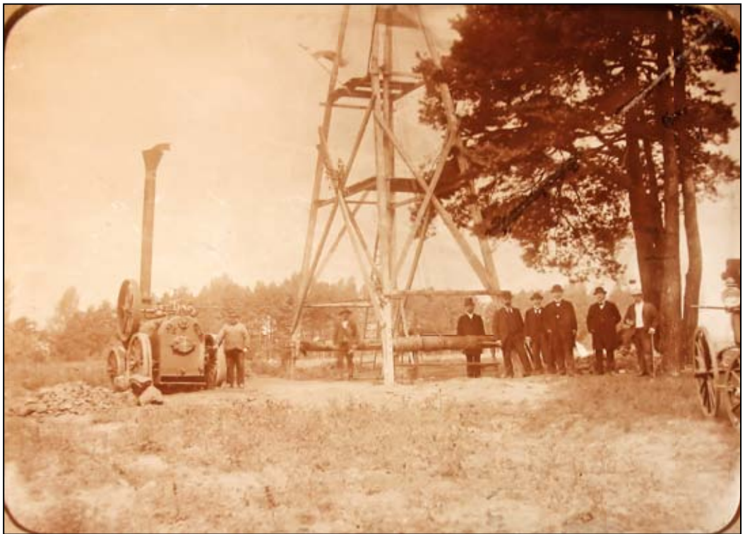
Rok 1901. Wykonywanie odwiertu studni głębinowej w Plantach. Pod drzewem prawdopodobnie przedstawiciele firmy.
