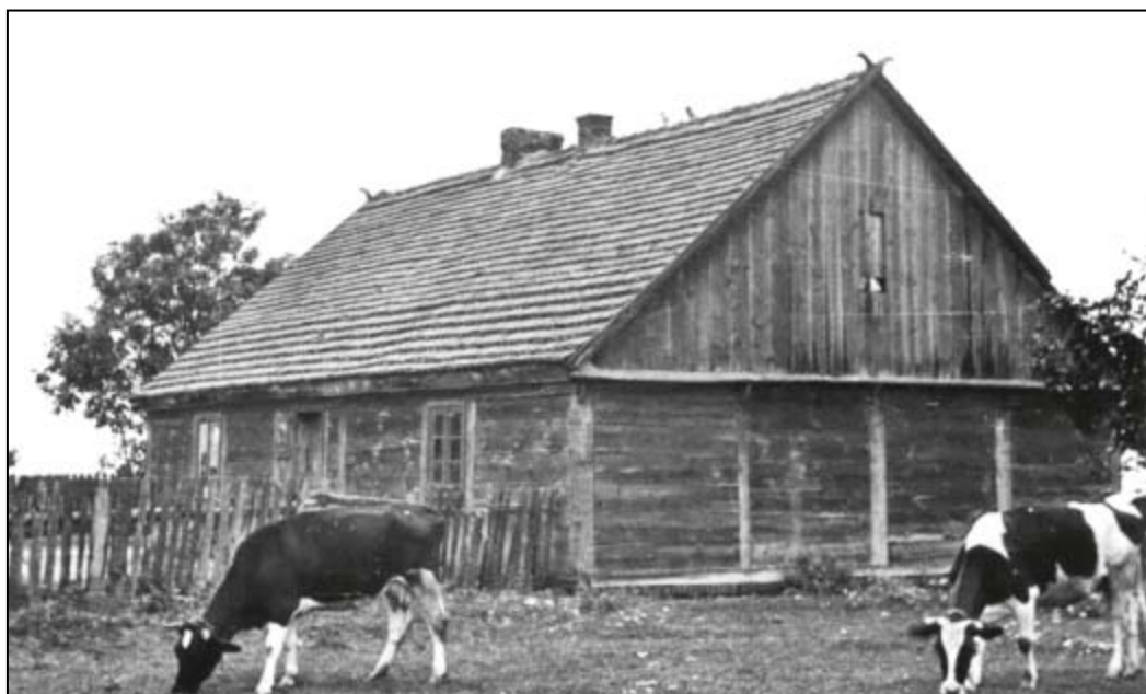
Fot. 1. Dom na słup, na dachu śparogi, zbudowany w 1882 r., Pleszówka pow. Pleszew (fot. St. Błaszczyk, 1958, Archiwum IEiAK).
