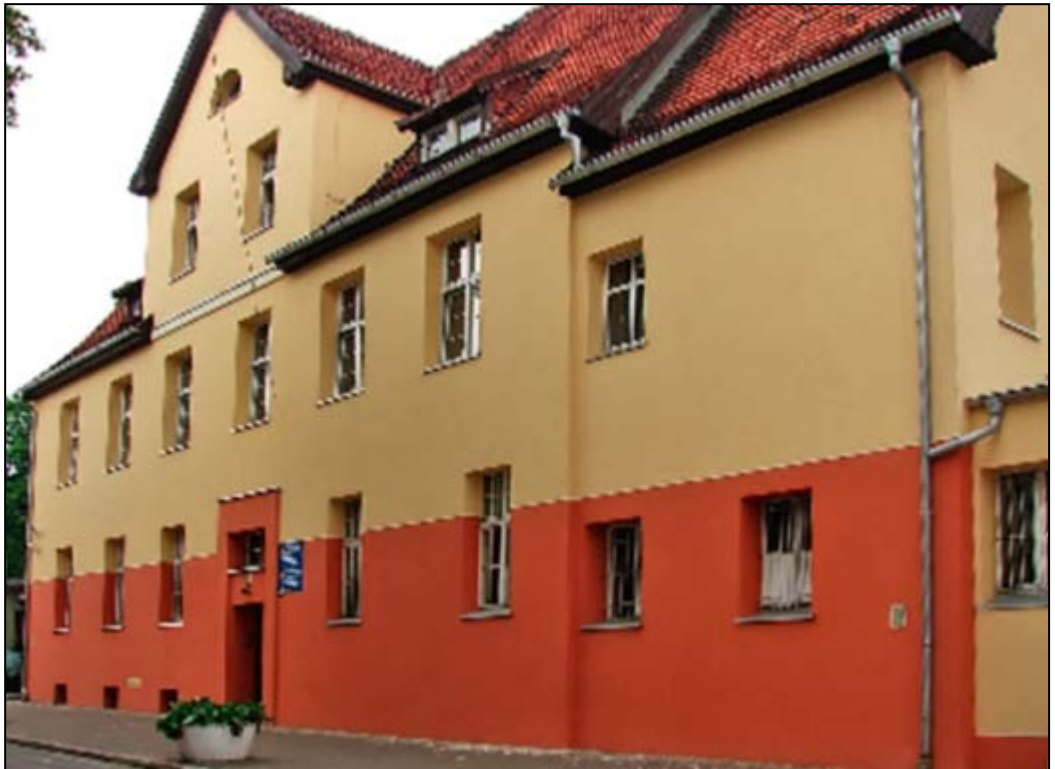
Budynek administracyjny po termomodernizacji.
