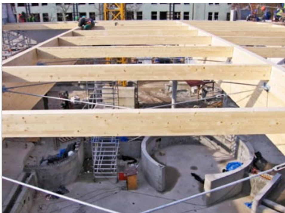
Kompleks sportowy w trakcie budowy
