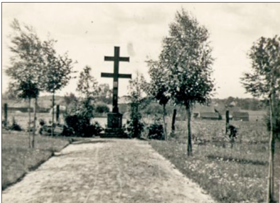
Karawaka (prawdopodobnie jeszcze przy ul. Marszewskiej, fot. przed 1939 r.)
