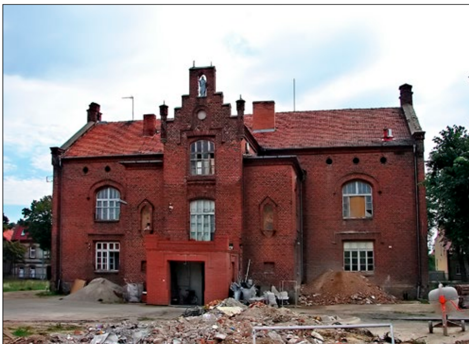
Dom Sióstr Salezjanek przed rozpoczęciem remontu
