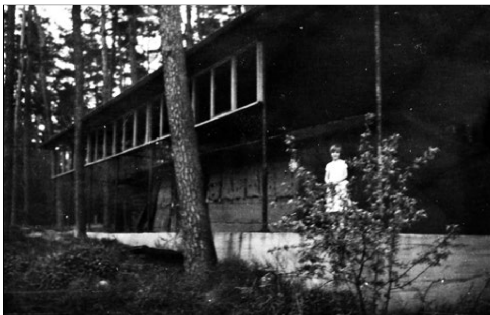
Pierwszy hangar w Gołuchowie (betlejemka). Widoczne fundamenty i elementy konstrukcji obecnego hangaru.
