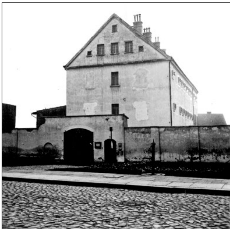
Budynek przy ul. Kaliskiej 24. Widok sprzed przebudowy w latach 1969–1970. Do 1956 r. Więzienie karno–śledcze, w latach 1957–1983 Zakład Poprawczy. Budynek wyburzony w 2003 r., po zakupie przez firmę prywatną.
