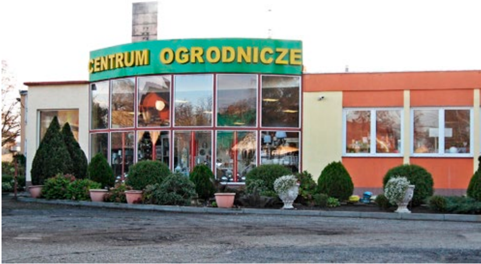
Zabudowania byłej siedziby Centrali przy ulicy Kaliskiej 78. Stan obecny.
