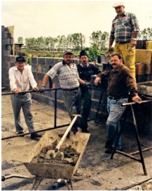
Rozbudowa schroniska. Zdjęcie – Roman Furmaniak.
