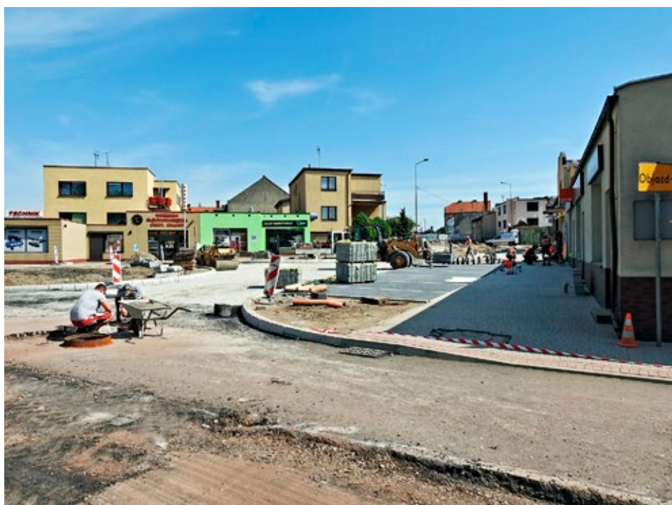
Przebudowa ulicy Św. Ducha i Sopałowicza, 2018 rok. Fot. UMiG
