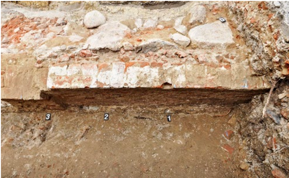
3. Pleszew, Rynek: widok na fragment fundamentu ceglanego budynku. Fot. G. Gmyrek
