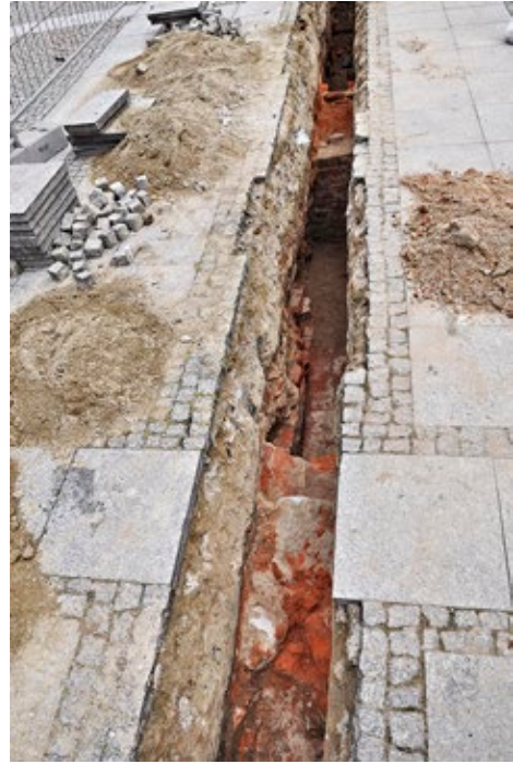
2. Pleszew, Rynek: wykop pod przyłącze wodociągowe i energetyczne z fundamentami i fragmentem podłogi budynku. Fot. G. Gmyrek
