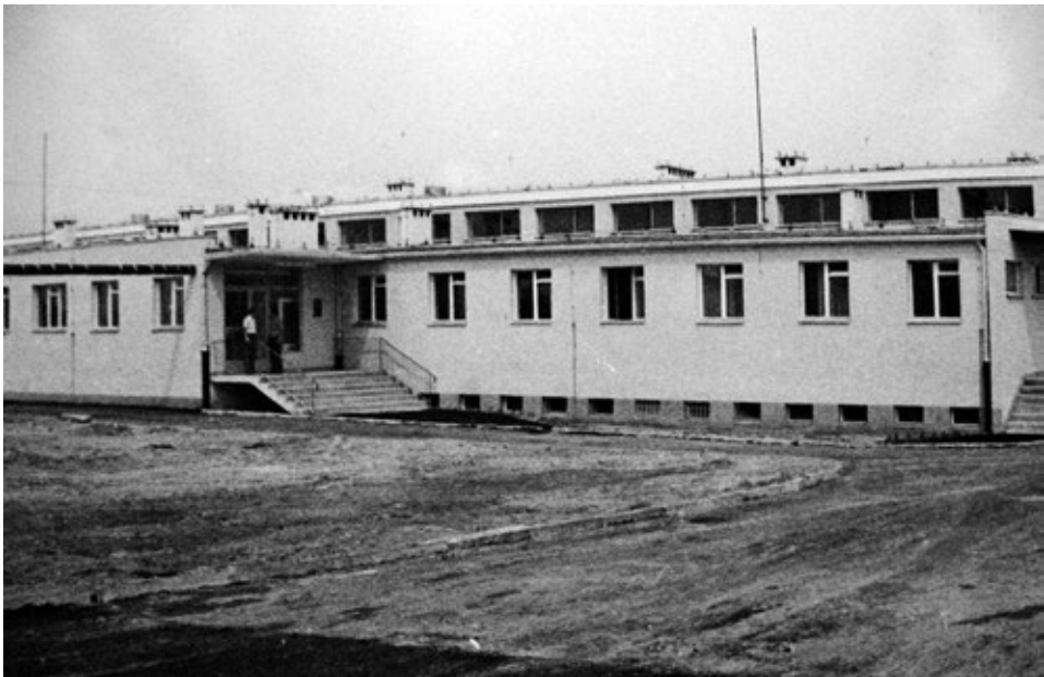
Hala produkcyjna, widok od strony południowej.
