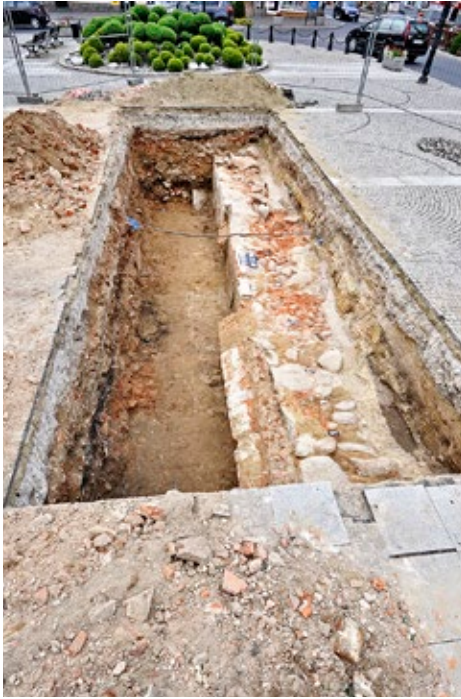
1. Pleszew, Rynek: widok na wykop pod nieckę fontanny z fundamentem budynku. Fot. G. Gmyrek
