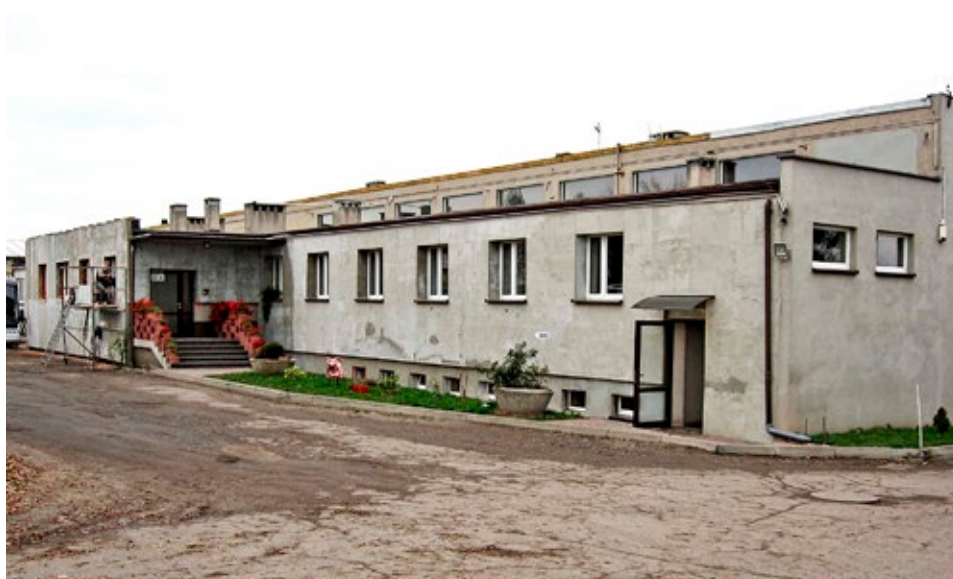
Zajezdnia autobusowa PLA, która mieści się na terenie byłej wytwórni – stan obecny.
