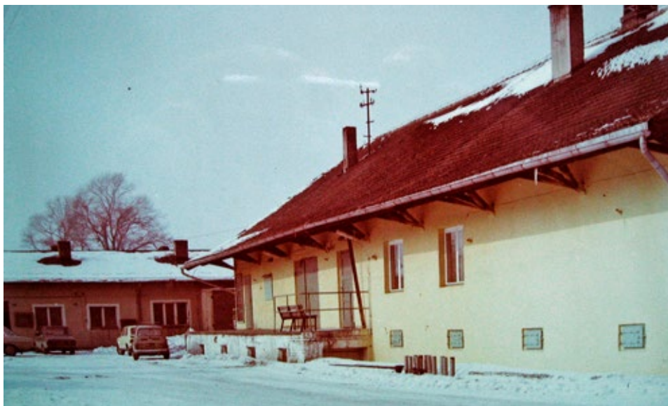
Magazyn z rampą załadunkową. Stan z roku 1979.
