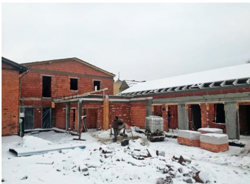
Dom Kultury w trakcie budowy, styczeń 2019 r. Foto: A. Bogacz.
