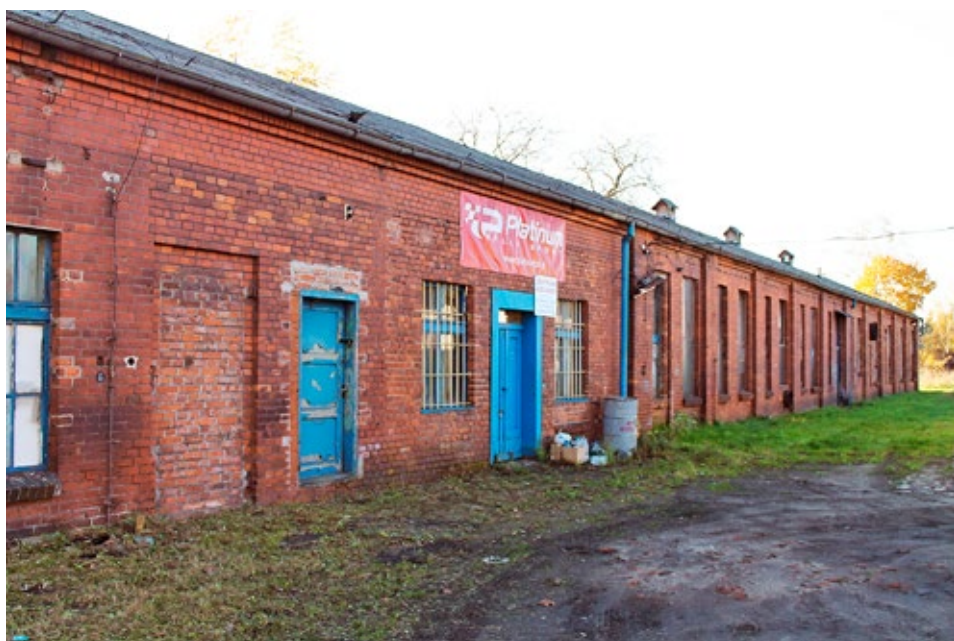
Stara parowozownia przed remontem, 2015 r. Foto: A. Bogacz.
