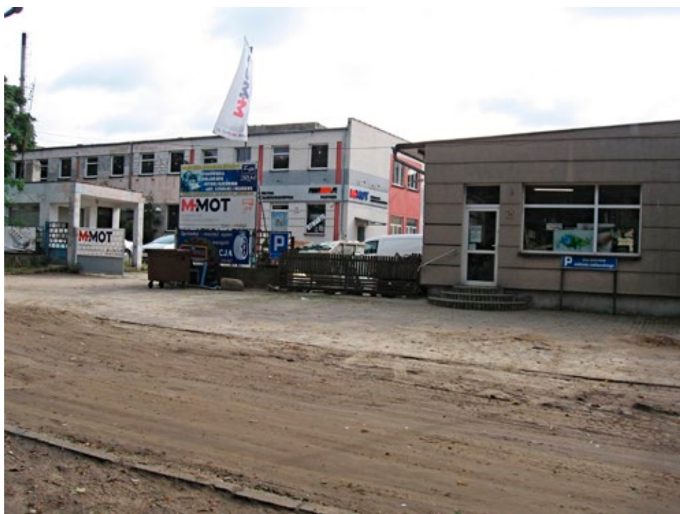
Obiekty Spółdzielni, widok od strony ulicy Ogrodowej. Stan z października 2020 r.
