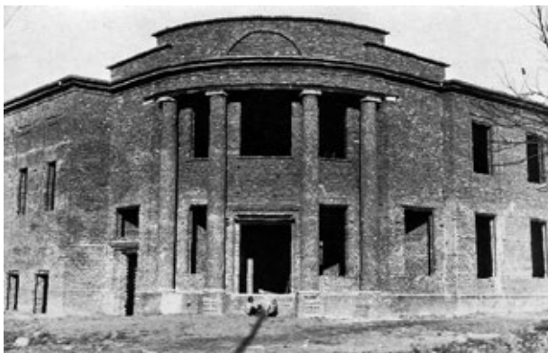
Dom Parafialny w budowie.
