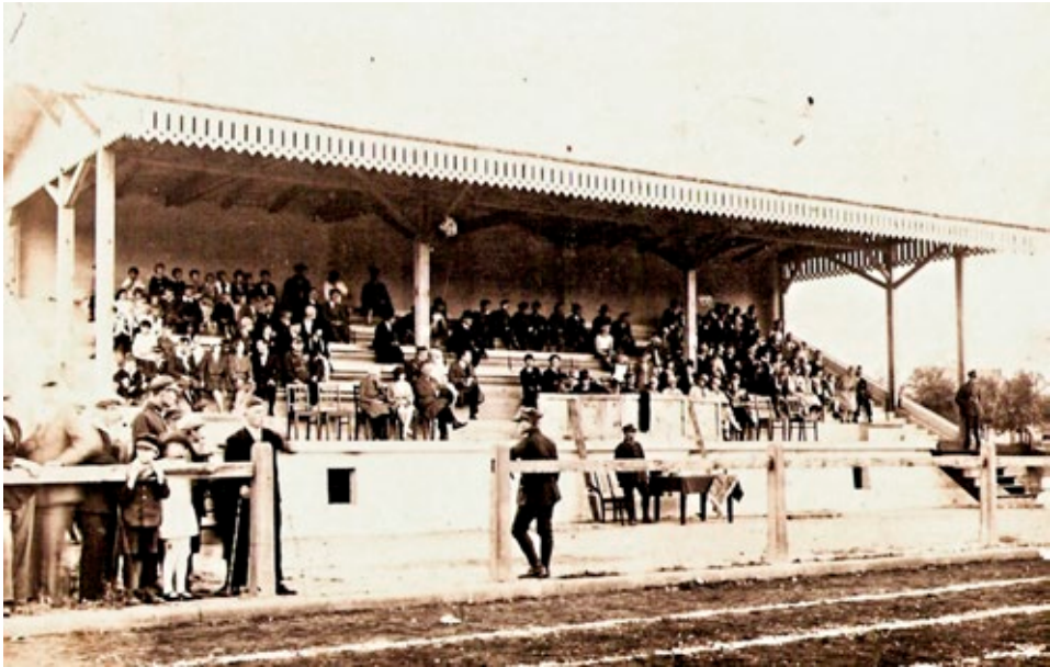
Trybuna główna stadionu 70 PP wybudowana w latach 1927–1929. Zdjęcie ze zbiorów Michała Kaczmarka
