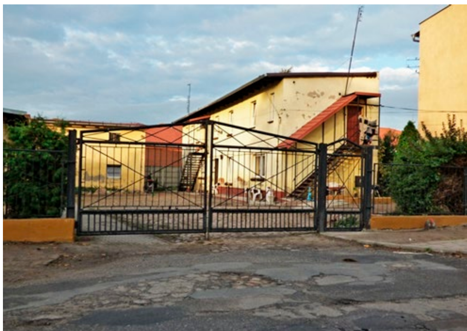
Budynek przy ul. Marszewskiej nr 3 (stan obecny). W latach 1977–1982 stacja pogotowia.
